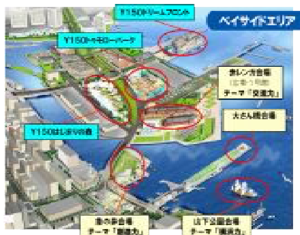
図1 ベイサイドエリア全景
